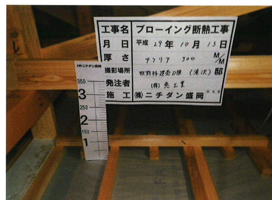
天井断熱材施工前
