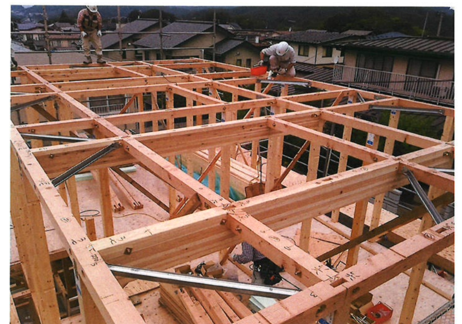
軸組組立状況
