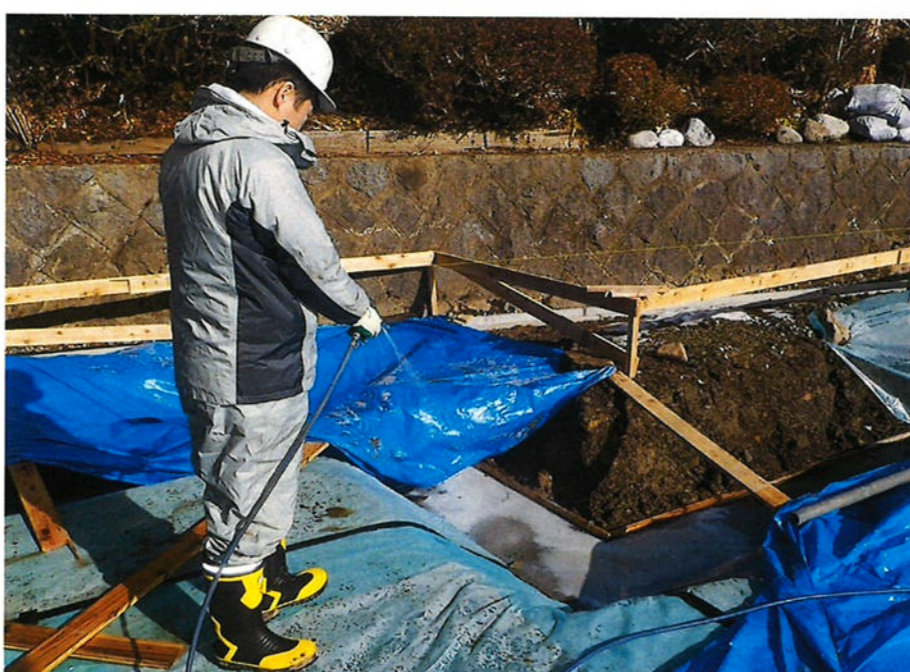
土壌防蟻処理
