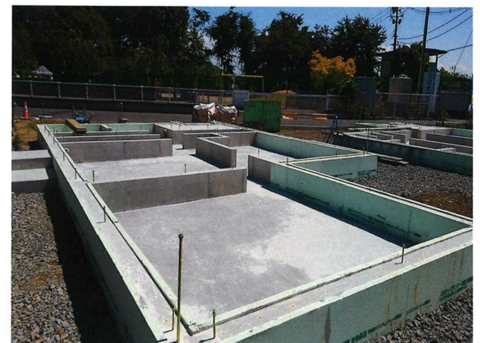
基礎工事完了
