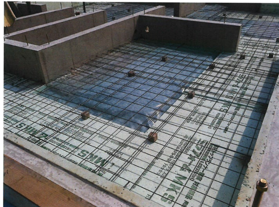
コンクリート打設前状況
