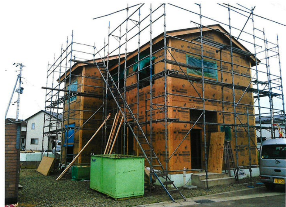
耐力面材設置状況
