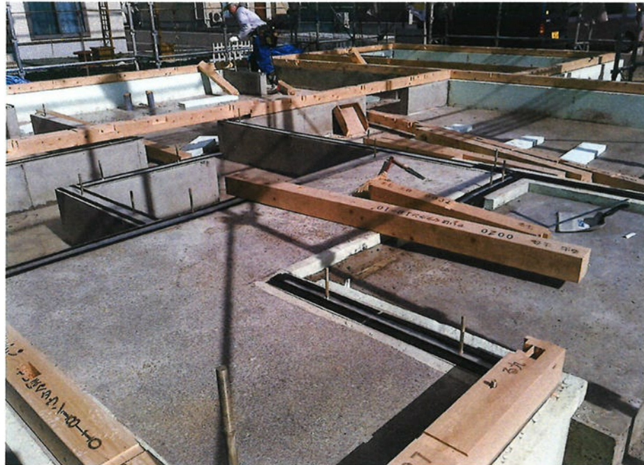
土台敷き状況
