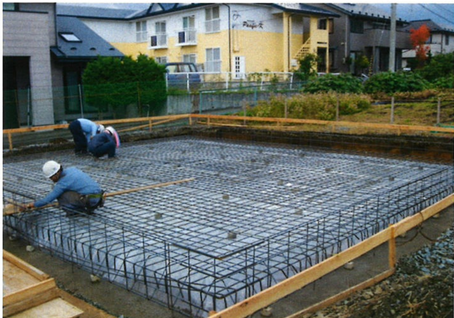
べた基礎配筋状況
