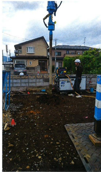
施工機械による改良工事状況
