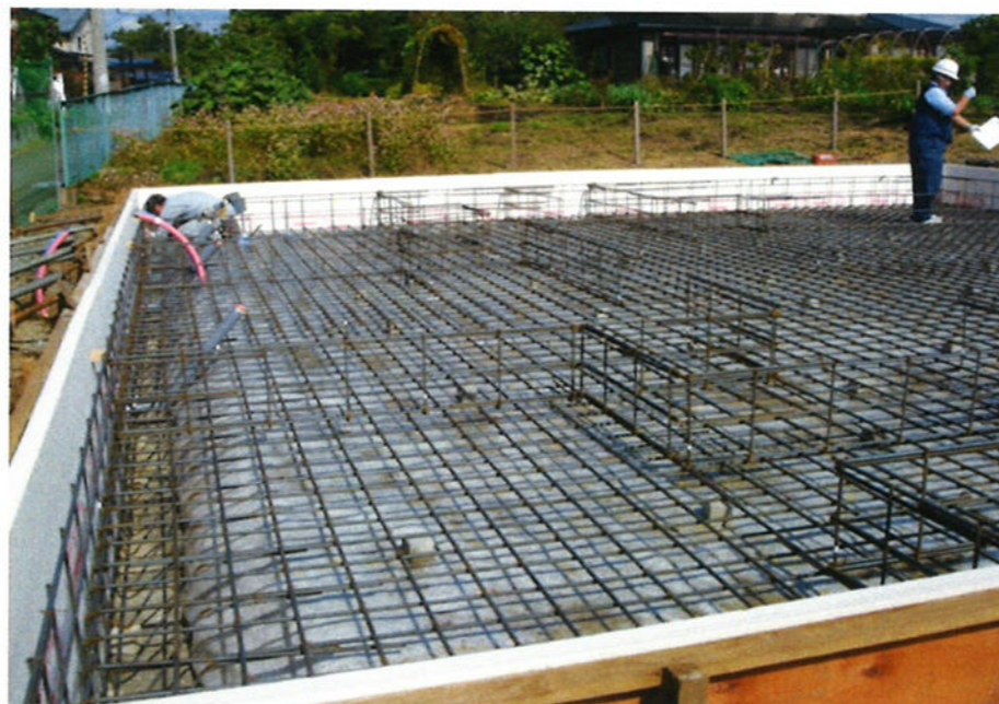
配筋・型枠設置 配筋検査状況
