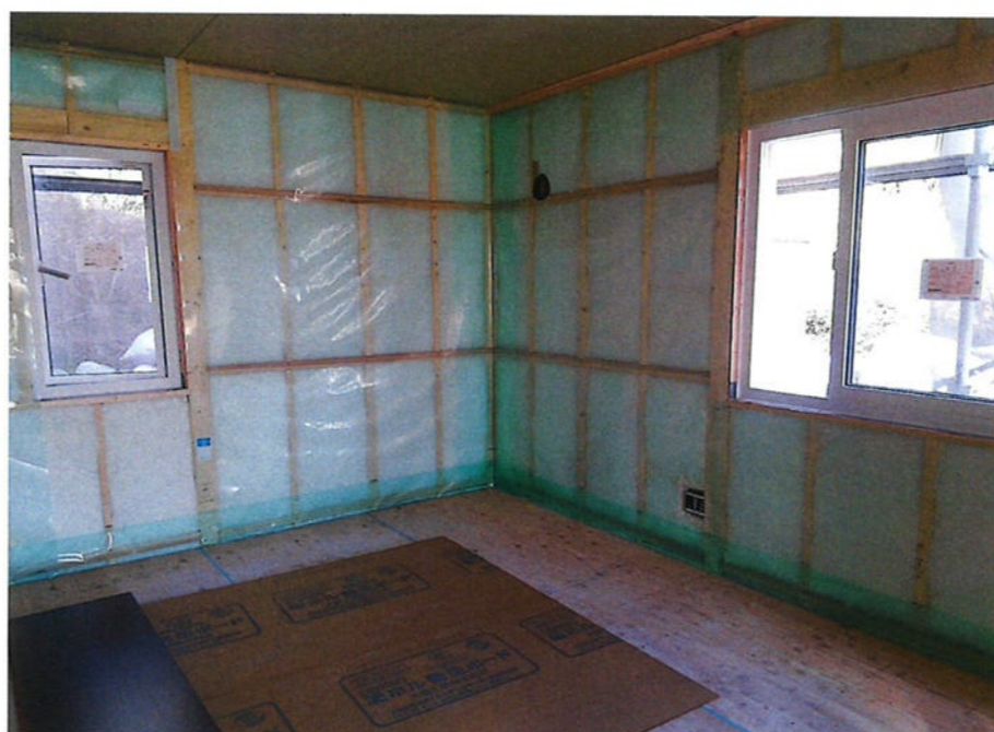
壁断熱設置・気密シート張状況
