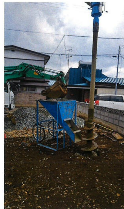
施工機械による改良工事状況
