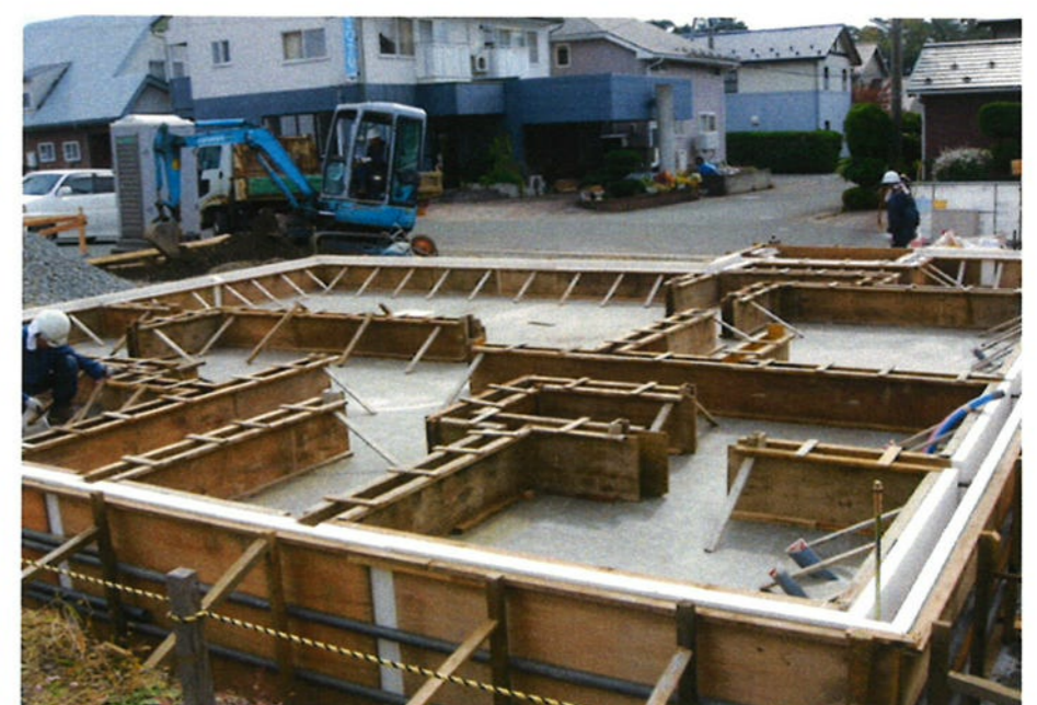
内部立上りコンクリート打設前状況
