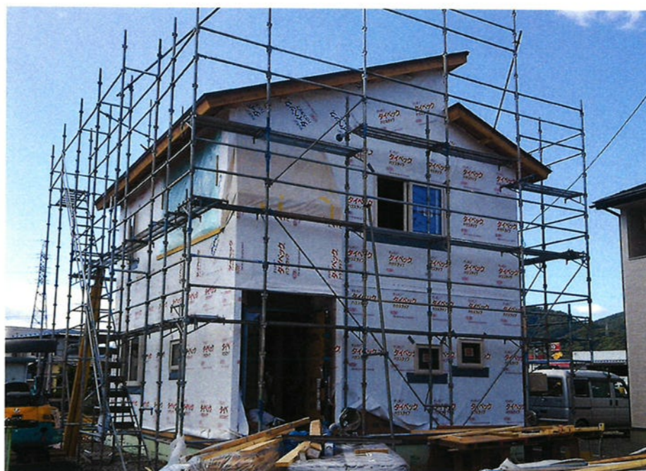
透湿防水シート張状況
