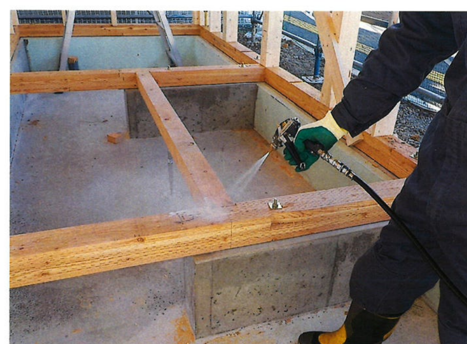
木部防蟻処理
