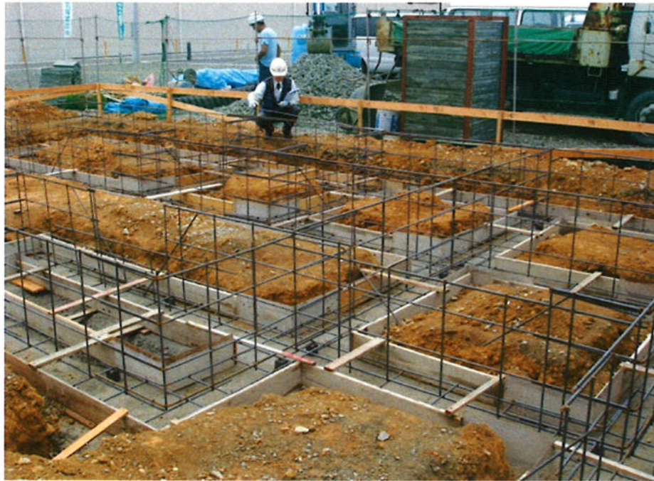
布基礎配筋検査状況
