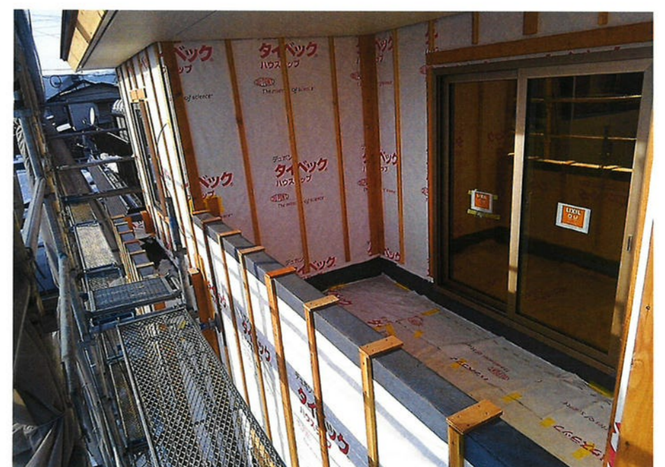
外壁下地通気胴縁設置状況
